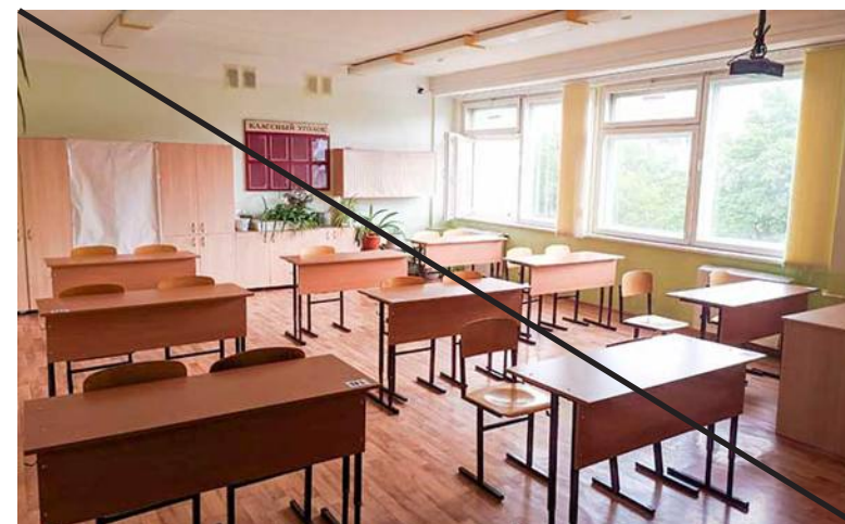
Плохо Линолеум под дерево
